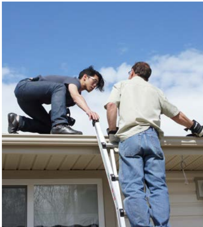
Figure 15 : Les voisins enlèvent les débris des gouttières pour réduire le risque d'incendie de la maison. Avec la permission de Intelli-feu Alberta, 2023.
