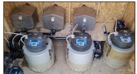
Débitmètres à benne basculante et échantillonneurs d'eau automatiques installés
